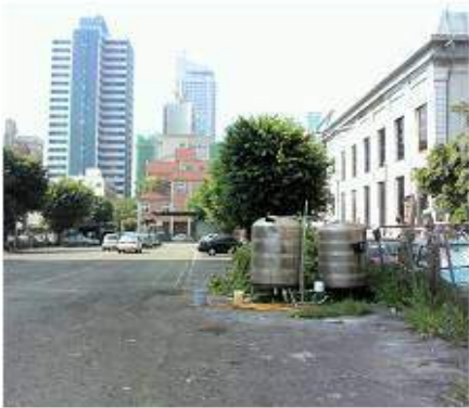
停車場水塔無蓋
