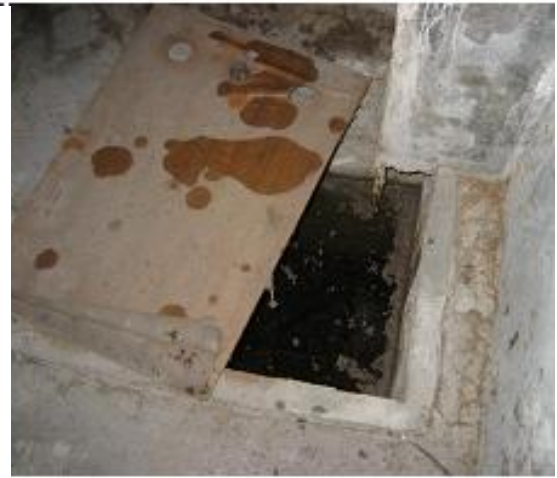
地下室污水池
