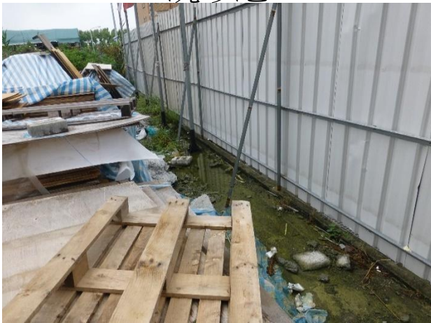
建築工地圍牆周邊
