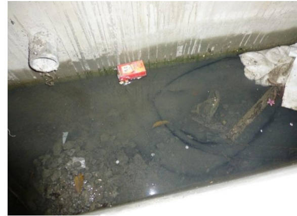
建築工地地面
