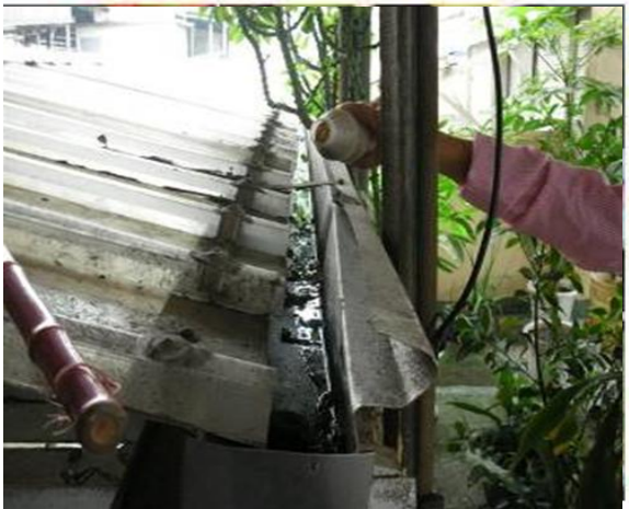
天溝(屋簷排水槽)
