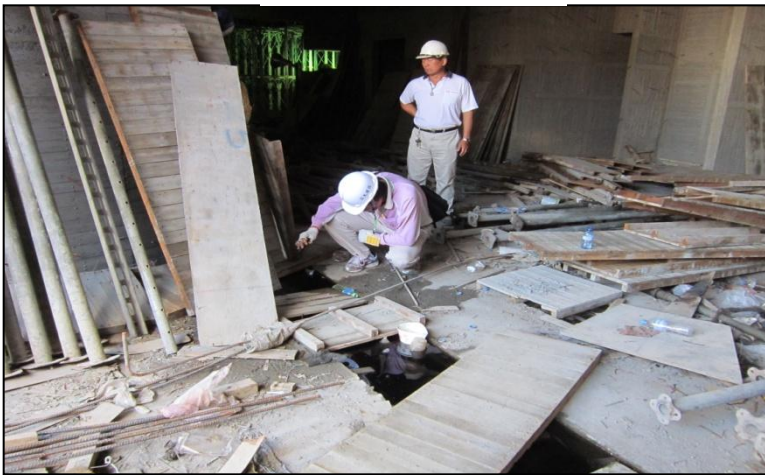
車道下方水溝
