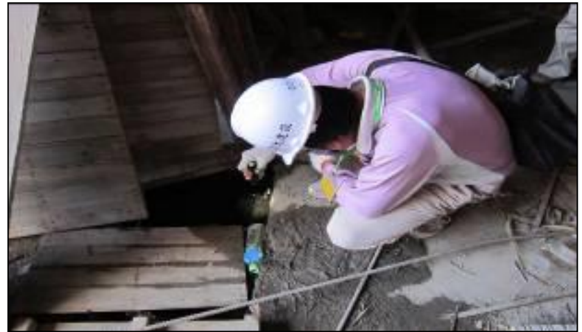
車道下方水溝
