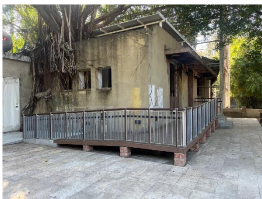
說明：原日軍步兵第二聯隊官舍群無障礙斜坡道
