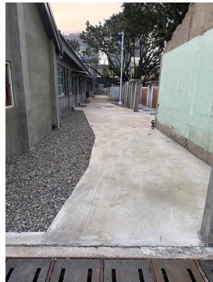
說明：仁德區二空新村原眷舍修復再利用工程全區無障礙通道
