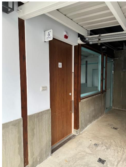
說明：仁德區二空新村原眷舍修復再利用工程新設無障礙廁所
