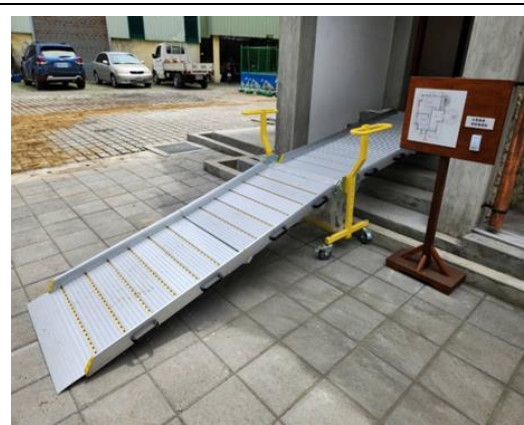
說明：原公園管理所修復工程提供無障礙坡道以創造友善無障礙環境
