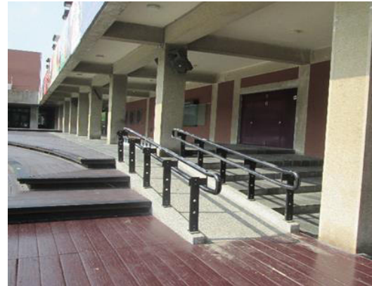
說明：臺南文化中心無障礙坡道。
