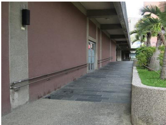
說明：臺南文化中心無障礙坡道。
