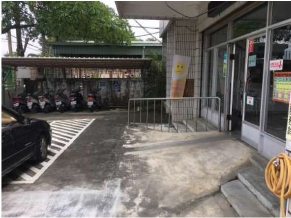
南化區無障礙坡道（整建前）
