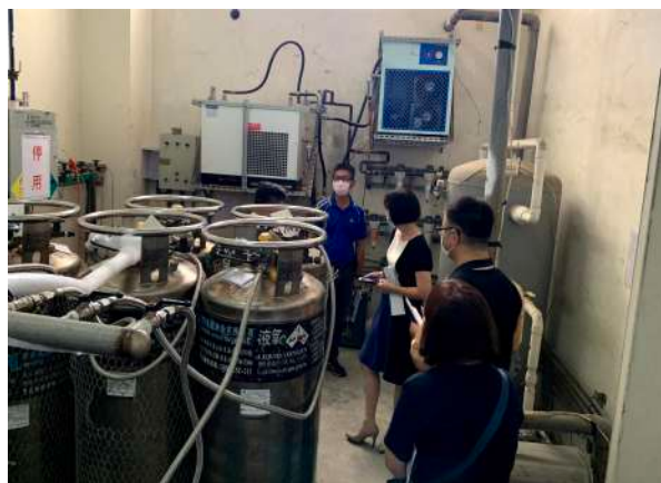
醫院環境及設備安全管理作業考核
