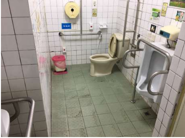
東山區無障礙廁所（整建前）
