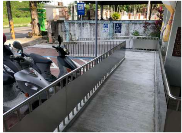
南化區無障礙坡道（整建後）
